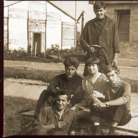
Barakk és téglapépület 1966-ban
