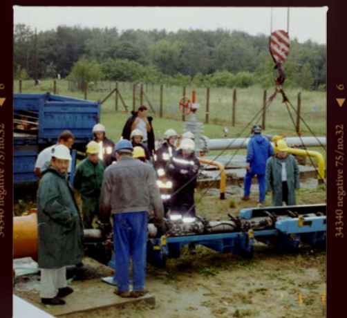
Intelligens görény a betoló szerkezetben
