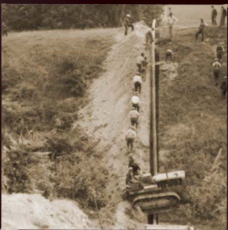
A zalai 8 colos vezeték induló szakasza
