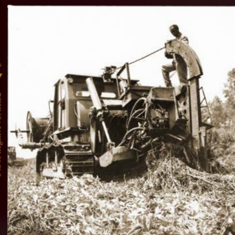
Hírközlő kábel fektetés
