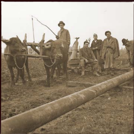
Ökör vontatású hegesztő felszerelés és a brigád
