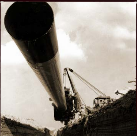
Vezetékepipítés az 1970-es évek végén
