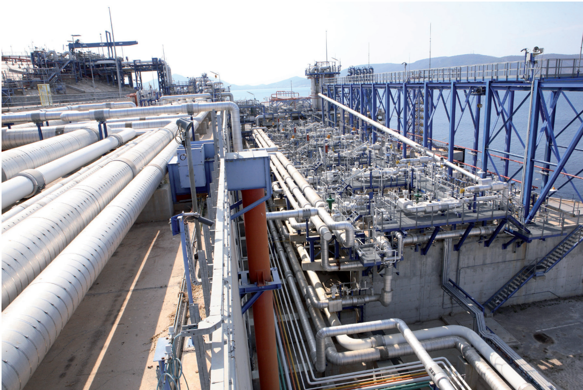
Revythoussa LNG terminal
